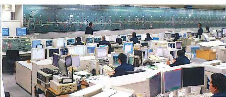
▲開業時に開発された列車集中制御装置（CTC）にかわり昭和47年から導入された、世界初の列車運行管理システム（PTC）となった新幹線運行管理システム（COMITRAC）。写真提供：JR東海
