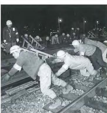
▲開業10年目に「若返り工事」と呼ばれる大規模な工事を行いました。これは経年劣化が見られる分岐器、架線などを入れ替えたもので、深夜の作業だけでは対応できない作業のため、半日程度列車の運行を休止して実施されました。絶え間ない保守作業が新幹線の安全を守ったのです。写真提供：交通新聞社
